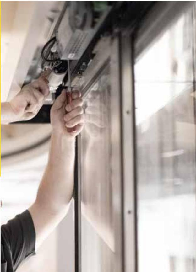
Anstelle einer aufwendigen Gesamterneuerung der ganzen Schiebetür ermöglicht MOD-SL von Gilgen Door Systems eine schnellere und kostengünstigere Modernisierung von Fremdanlagen.
